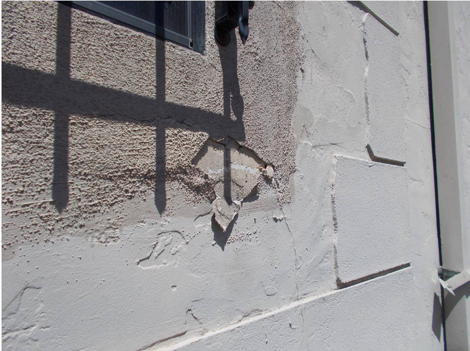
DSCN3880 Deteriorating stucco.
