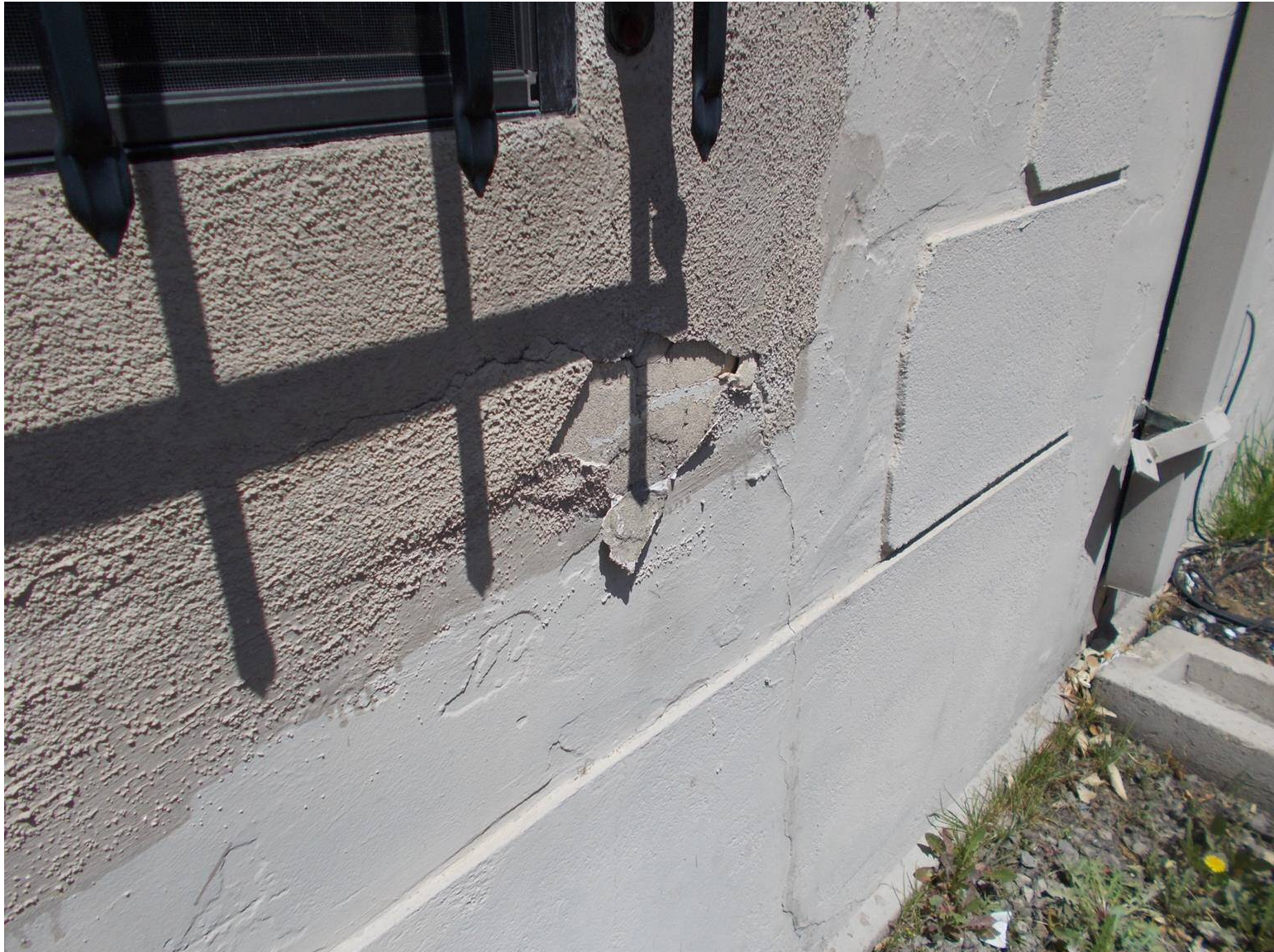
DSCN3879 Deteriorating stucco.
